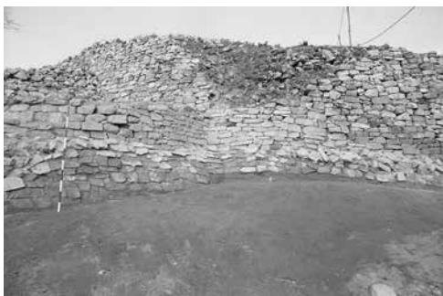
여주 파사성 남벽 하단 보축 상태(왼쪽)와 외성벽 보축 상태(오른쪽)
