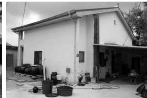
배면, 측면 전경
