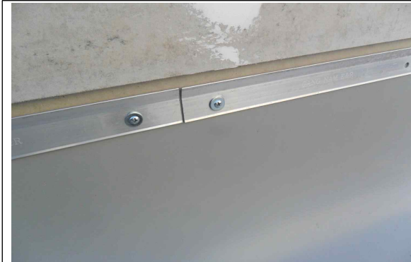
[사진4] TR-Bar(후레싱) 시공
