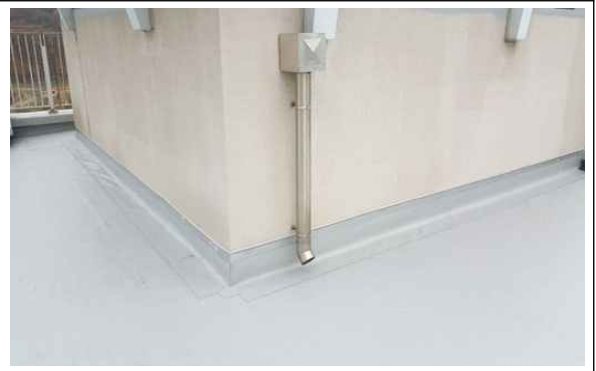
[사진5] ㄱ자-Bar(후레싱) 시공
