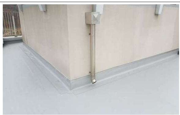
[사진5] ㄱ자-Bar(후레싱) 시공
