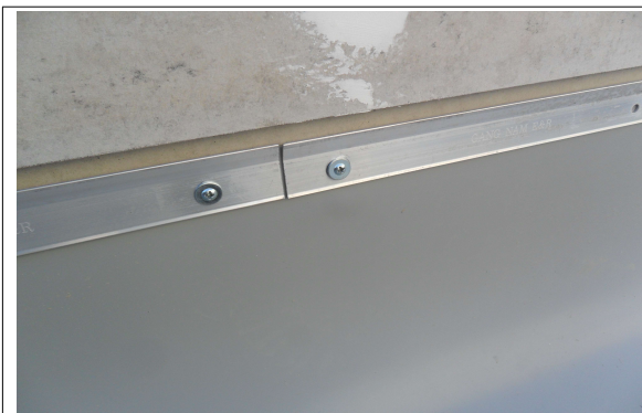
[사진4] TR-Bar(후레싱) 시공
