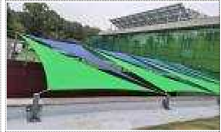
선셰이드 설치 후
