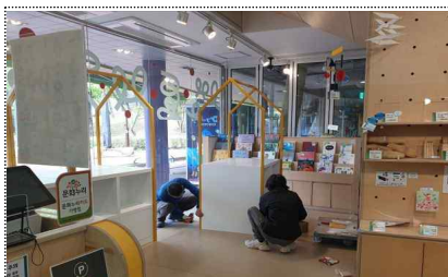
매대 추가 설치
