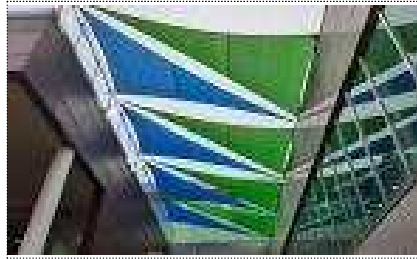
선셰이드 설치 후
