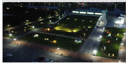
경기도미술관 야외경관조명 설치
